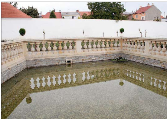
Obr. 91: Hladina bazénu u Ptáčnice s ústím skimmeru. (Foto J. Obšivač, 2016)
