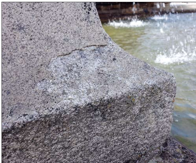
Obr. 27: Detail soklu sochy z žuly, degradace kamene lokálním odloučením jeho povrchové vrstvy. (Foto J. Olšan, 2016)
