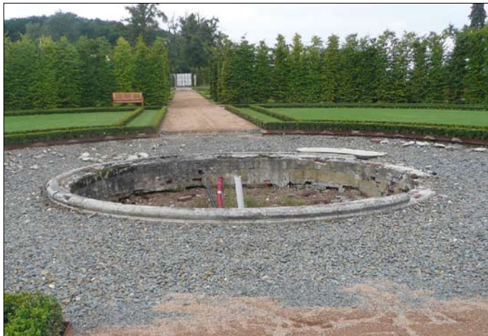
Obr. 33: Štáblovice u Opavy – fontána z druhé poloviny 19. století na parteru zámecké zahrady. Stěna bazénu fontány byla vyzděna z cihel a opatřena cementovým potěrem, profilovaná koruna byla vymodelována z umělého kamene. (Foto E. Olšanová, 2014)
