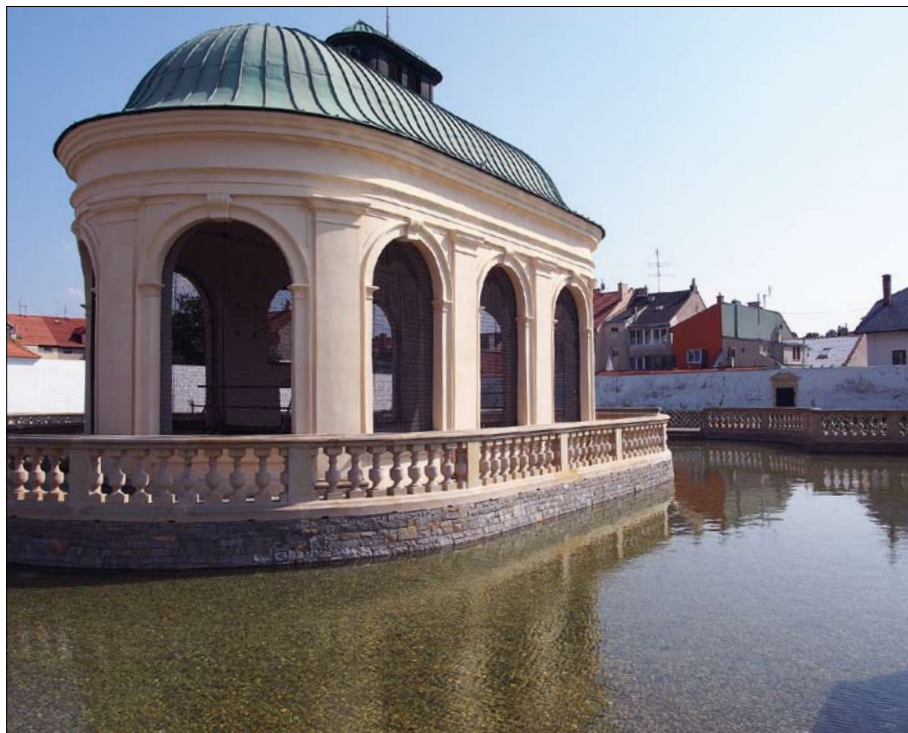
Obr. 13: Kroměříž – kromě vrstvy kačírku na dně bazénu má na dobrou čistotu vody v ptáčnici Kovětné zahrady pravděpodobně vliv také smývání měděnky ze střechy stavby při dešti. (Foto L. Křesadlová, 2016)
