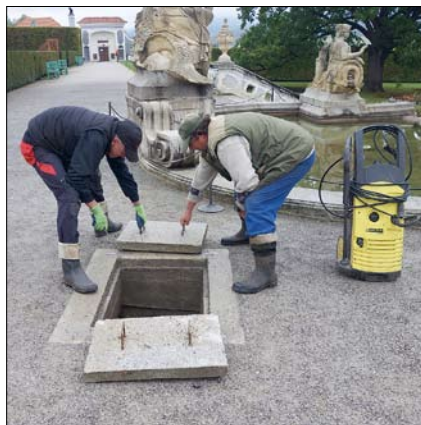
Obr. 53: Český Krumlov, Kaskádová fontána v zámecké zahradě – dvoudílný kamenný poklop kryje vstup do 2,5 m hluboké podzemní šachty, v níž je umístěno technologické zařízení fontány, jež je provozována s uzavřeným oběhem vody. Během vstupu pracovníků do šachty je rozmístěno mobilní ohrazení, jež zamezuje přístupu nepovolaných osob k otevřenému vstupu do šachty, ohrazení je doplněno informační výstražnou tabulkou. (Foto J. Olšan, 2016)
