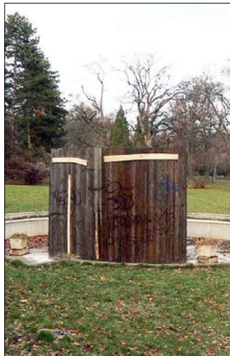
Obr. 57: Brno, park Lužánky – systém zimní ochrany fontány se sousoším, stav před montáží a po montáží ochranné konstrukce. (Foto L. Křesadlová, 2016)
