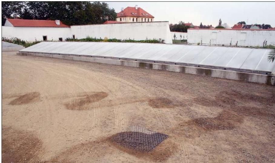
Obr. 97: Vstup do retenční nádrže v prostoru zahradnictví. (Foto J. Obšivač, 2016)
