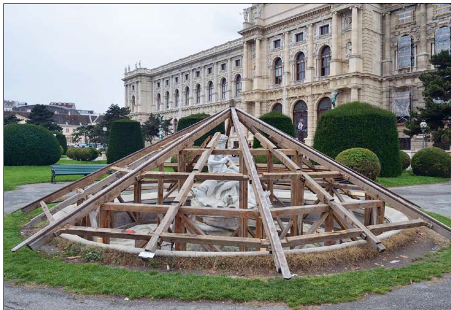
Obr. 58: Vídeň, Rakousko, Náměstí Marie – fontána s Najádami a Tritóny, stav během montáže ochranné konstrukce ze dřeva. ( https://commons.wikimedia.org/wiki/File:Tritonen-_und_Najadenbrunnen,_frost_protection_02.jpg )
