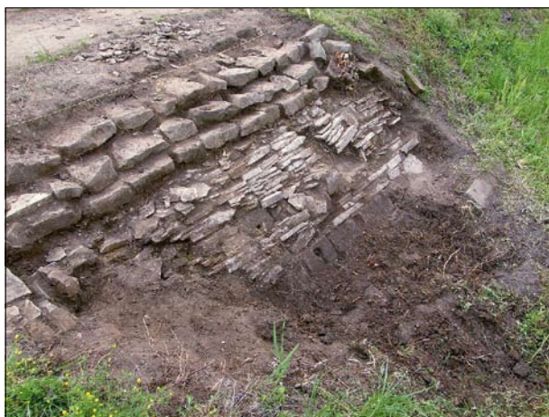
Obr. 86: Původní barokní konstrukce západního Pstružského rybníka odkrytá při archeologickém výzkumu. (Foto J. Janál, 2009)
