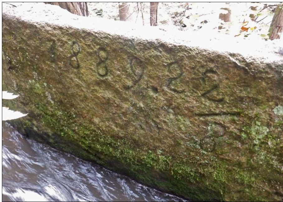
Obr. 76: Nové Hrady – letopočet ve stěně vodního náhonu u vodopádu v parku Terčino údolí. (Foto J. Janál, 2014)
