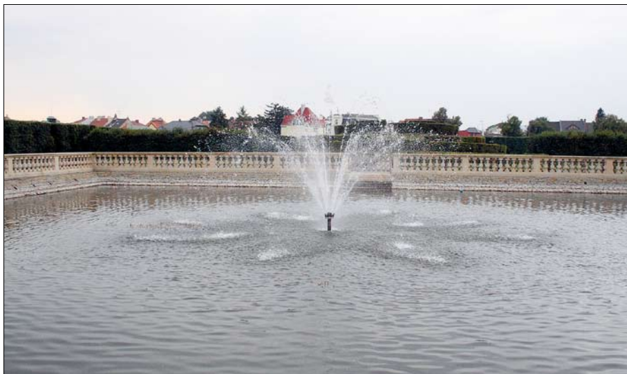
Obr. 96: Snížení vodní hladiny nežádoucím způsobem obnažilo konstrukci vodotrysku. (Foto J. Obšivač, 2016)
