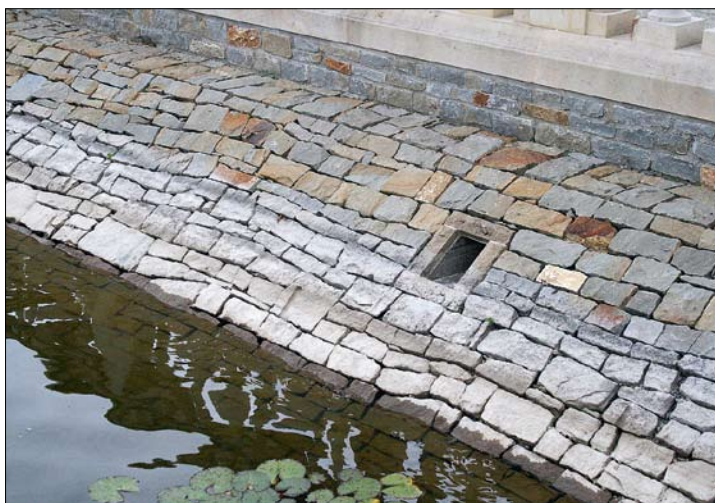
Obr. 89: Skimmer skrytý v konstrukci břehu východního Pstružího rybníka. (Foto, J. Obšioač, 2016)
