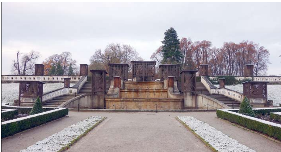
Obr. 120: Kaskádová fontána po dokončení montáže zimních krytů. (Foto J. Olšan, 2016)
