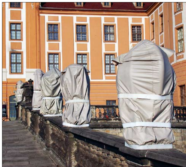
Obr. 63: Zámek Moritzburg, Německo – příklad použití textilních krytů bez nosné konstrukce při zimní ochraně soch. (zdroj: Deutsche Bundesstiftung Umwelt)
