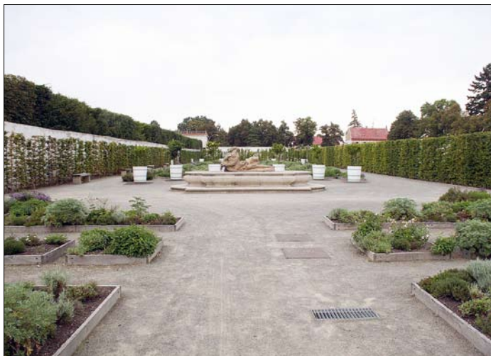
Obr. 94: Vstupy do strojovny a vyústění ventilační šachty před obnovenou Neptunovou fontánou. (Foto J. Obšiváč, 2016)
