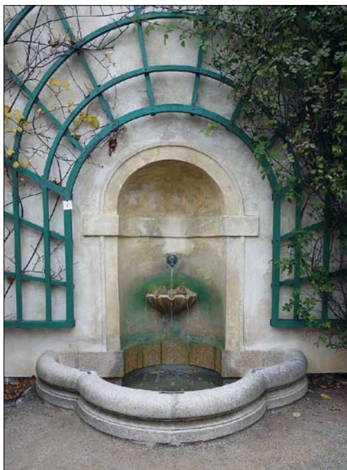
Obr. 50: Český Krumlov, Zahrada Na baště na 5. zámeckém nádvoří – kašna s uzavřeným oběhem vody, voda v systému kašny je chemicky ošetřena. Návštěvníci jsou informováni piktogramem, že voda není pitná. (Foto J. Olšan, 2016)
