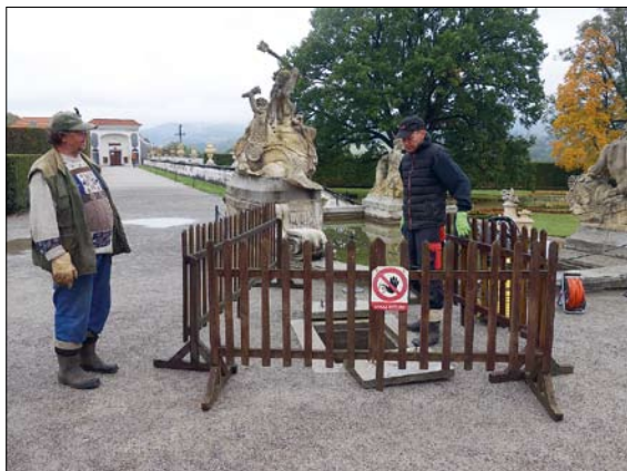
Obr. 53: Český Krumlov, Kaskádová fontána v zámecké zahradě – dvoudílný kamenný poklop kryje vstup do 2,5 m hluboké podzemní šachty, v níž je umístěno technologické zařízení fontány, jež je provozována s uzavřeným oběhem vody. Během vstupu pracovníků do šachty je rozmístěno mobilní ohrazení, jež zamezuje přístupu nepovolaných osob k otevřenému vstupu do šachty, ohrazení je doplněno informační výstražnou tabulkou. (Foto J. Olšan, 2016)
