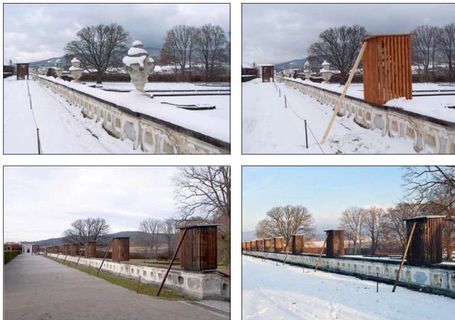
Obr. 54: Český Krumlov – zkouška prototypu zimního krytu kamenných dekorativních oáz na balustrádě u Kaskádové fontány, zimní aspekt balustrády po osazení celého souboru ochranných krytů. (Foto P. Slavko, 2005, 2011)
