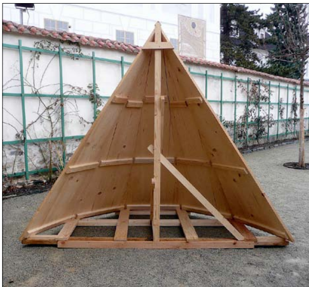
Obr. 59: Český Krumlov, Zahrada Na baště na 5. nádvoří zámku – kašna je v zimním období odstavena z provozu a chráněna dřevěným zimním krytem. (Foto J. Olšan, 2013)
