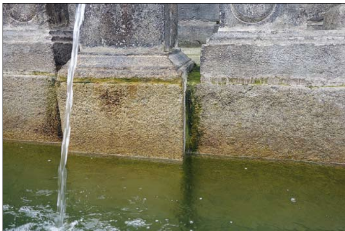
Obr. 28: Napadení povrchu kamene zkráplěného vodou řasami. (Foto J. Olšan, 2016)
