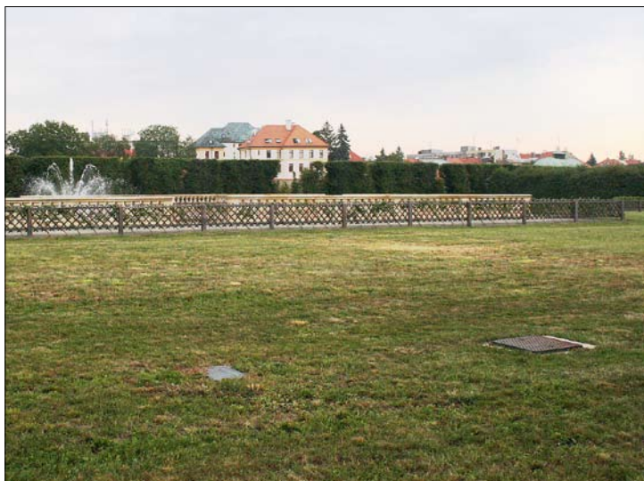
Obr. 88: Vstup do strojovny a vyústění větrací šachty technologické části Pstružských rybníků. (Foto J. Obšiváč, 2016)
