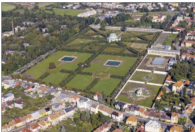
Obr. 82: Letecký pohled na Koethnou zahradu po obnově. (Foto A. Karban, 2014)
