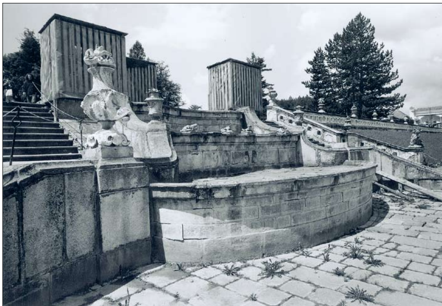
Obr. 110: Stav kaskádové fontány v roce 1995, sousoší na horním stupni fontány byly chráněny před poškozením dřevěnými kryty. (Foto L. Horák, 1995)
