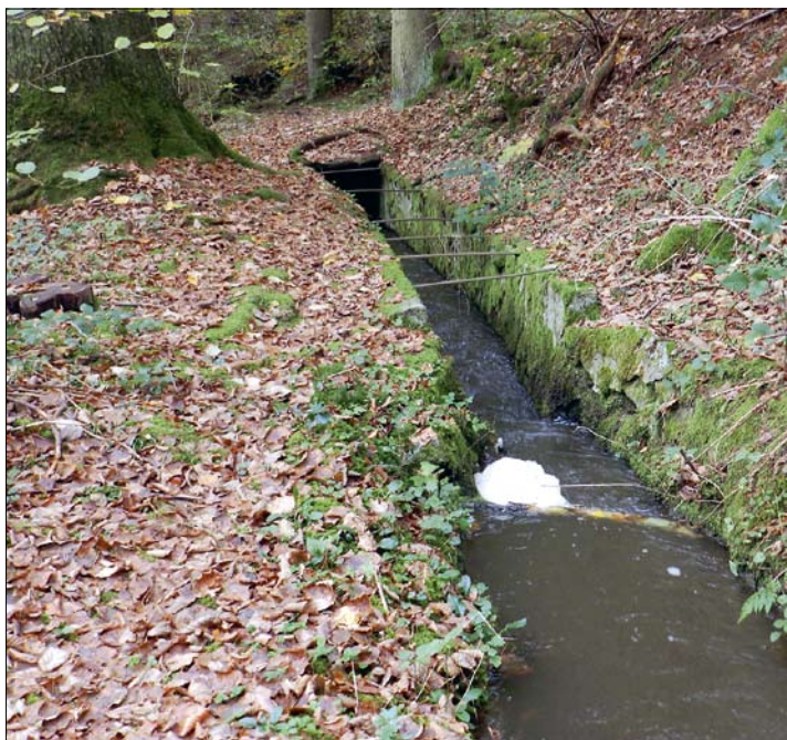
Obr. 75: Nové Hradky – vodní náhon k vodopádu v parku Terčino údolí, jenž je z části otevřený, zčásti krytý. (Foto J. Janál, 2014)
