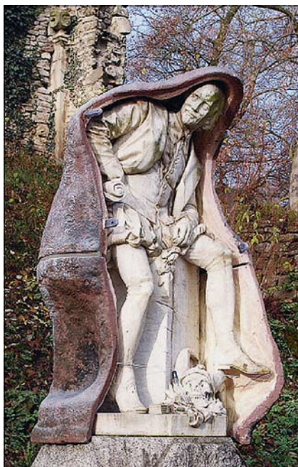
Obr. 65: Výmara, Německo – pomník Williama Shakespeara v parku na řece Ilm, ukázka použití systému zimní ochrany „Ciccum Leichtbau Gehause“, stav před osazením přední části krytu. (Foto web fy Ciccum, 2009)
