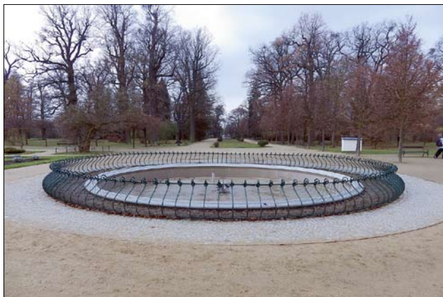
Obr. 47: Přerov, park Michalov – rekonstruovaná fontána s dekorativním ochranným oplocením. (Foto K. Křesadlová, 2014)
