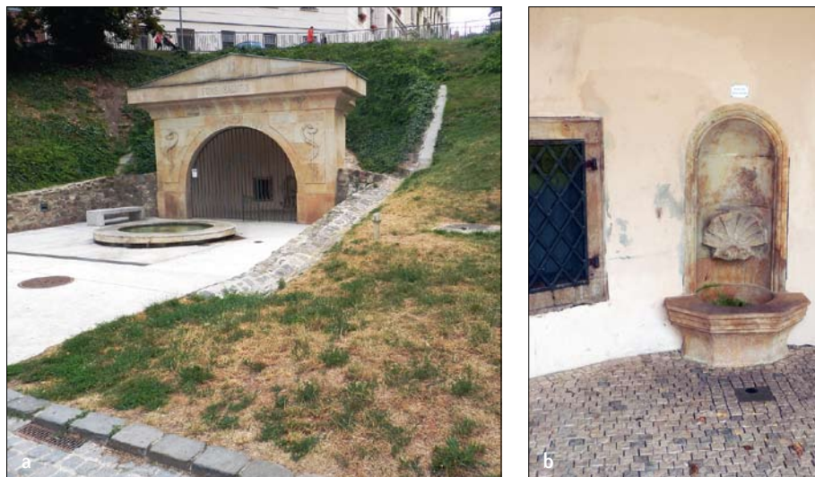
Obr. 22: Brno – pramen zdraví: a – vlevo od nadzemního objektu je patrný vstupní poklop do podzemní strojovny, b – voda do prameníku se pouští pomocí nášlapné armatury v podlaze. (Foto Z. Žabička, 2012)
